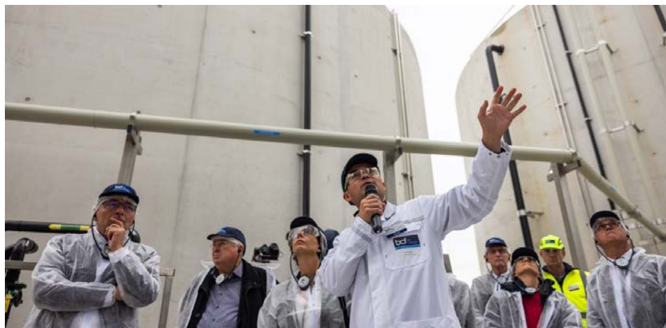
Visite de la station de traitement d'eau et de REUSE
